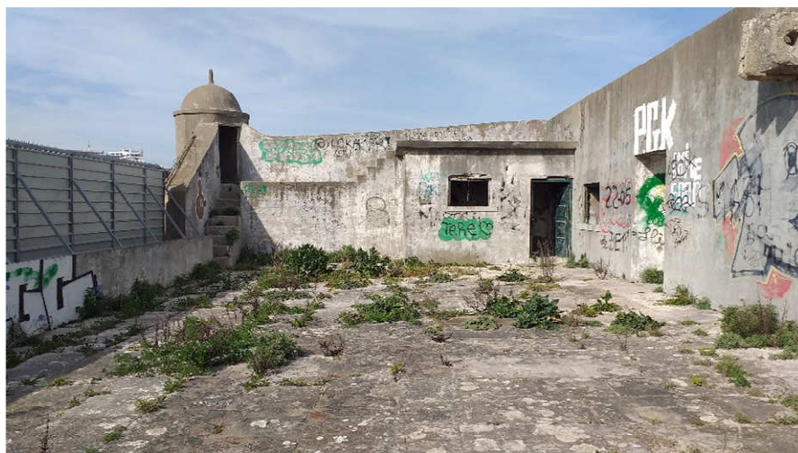
Fig. a 7: Bateria, vista no sentido Sul-Norte; ao fundo a guarita Noroeste. Note-se uma pequena divisão informal, como que clandestina, de apoio. À direita, a porta para o aquartelamento e, no topo superior direito uma estrutura (duas pedras aparelhadas dispostas verticalmente com um buraco a meio) de função indeterminada.
