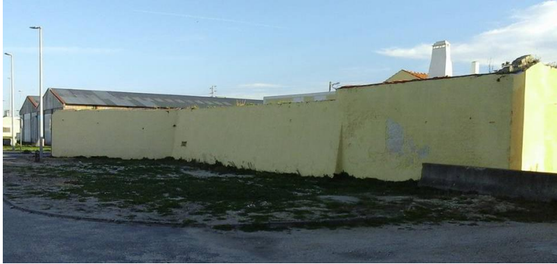
Fig. a 7 - Forte de Aveiro: flanco norte do Baluarte Norte, construído muito provavelmente na 2. a metade do séc. XVI; nunca concluído.
