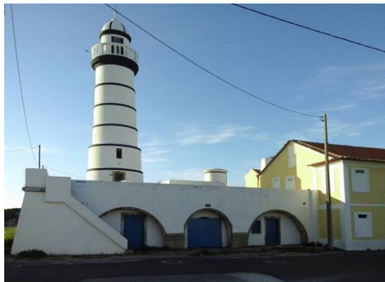
Fig. a 6 - Forte de Aveiro: frente Leste do Baluarte Sul. Note-se o assoreamento e o alteamento da cota actual do sítio de implantação do Forte, assim tornado artificialmente atarracado. À esquerda, a pequena escada de acesso à plataforma superior do baluarte e à torre de sinais.
