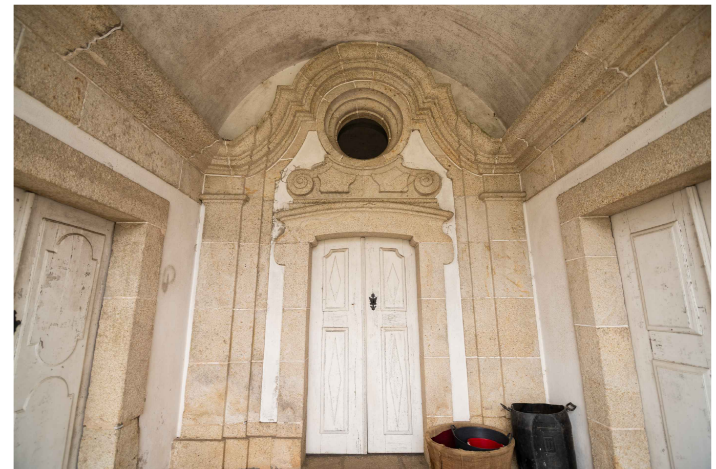
Pormenor da entrada do piso 1
